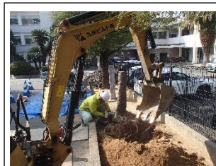
枯れた松を伐採し掘り起こしています！
