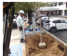
土が流れないようにブロックで固定！
