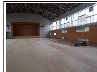
フロアシートを貼る前の体育館の床板。
