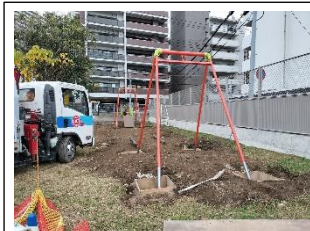
北斗の丘に新しく設置しているターザンロープ。
